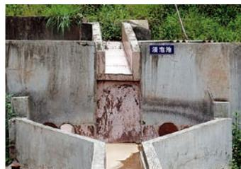
写真4 二次発酵槽及び排水経路
